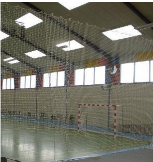
Spærrenet ført på 8 mm rebkant med ringe i top
